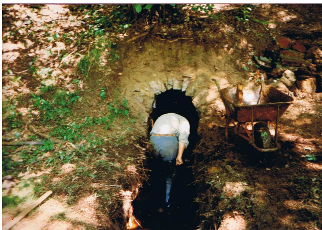
Rok 1997 - obnova ústí starého důlního díla, dědičné štoly Svatá Anna z roku 1789 v údolí mezi Loučkami a Loktem vedle trati lokální železnice.
